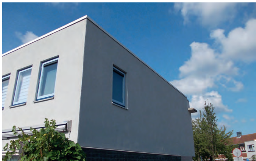
▲ Met behulp van de 'Inspectiemethodiek pleisterwerk' is de kwaliteit en conditie van buitengevelisolatie en ongeïsoleerde pleistersystemen meetbaar.
