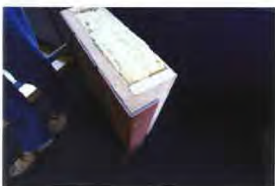
► Opbouw van de geïsoleerde prefabgevel met steenstrips.
