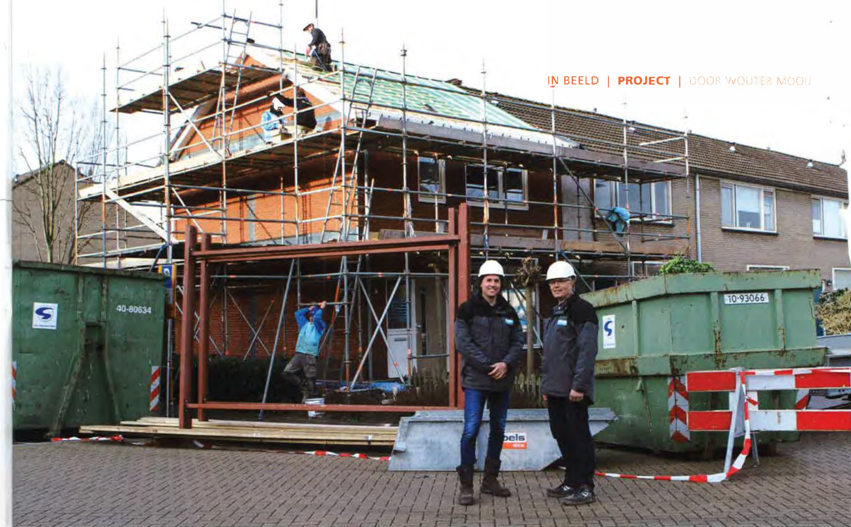
▲ Sander Willems (links) en uitvoerder Arie van der Meer voor een kopwoning die in vijf dagen tijd wordt opgewaardeerd van energielabel E naar A.
